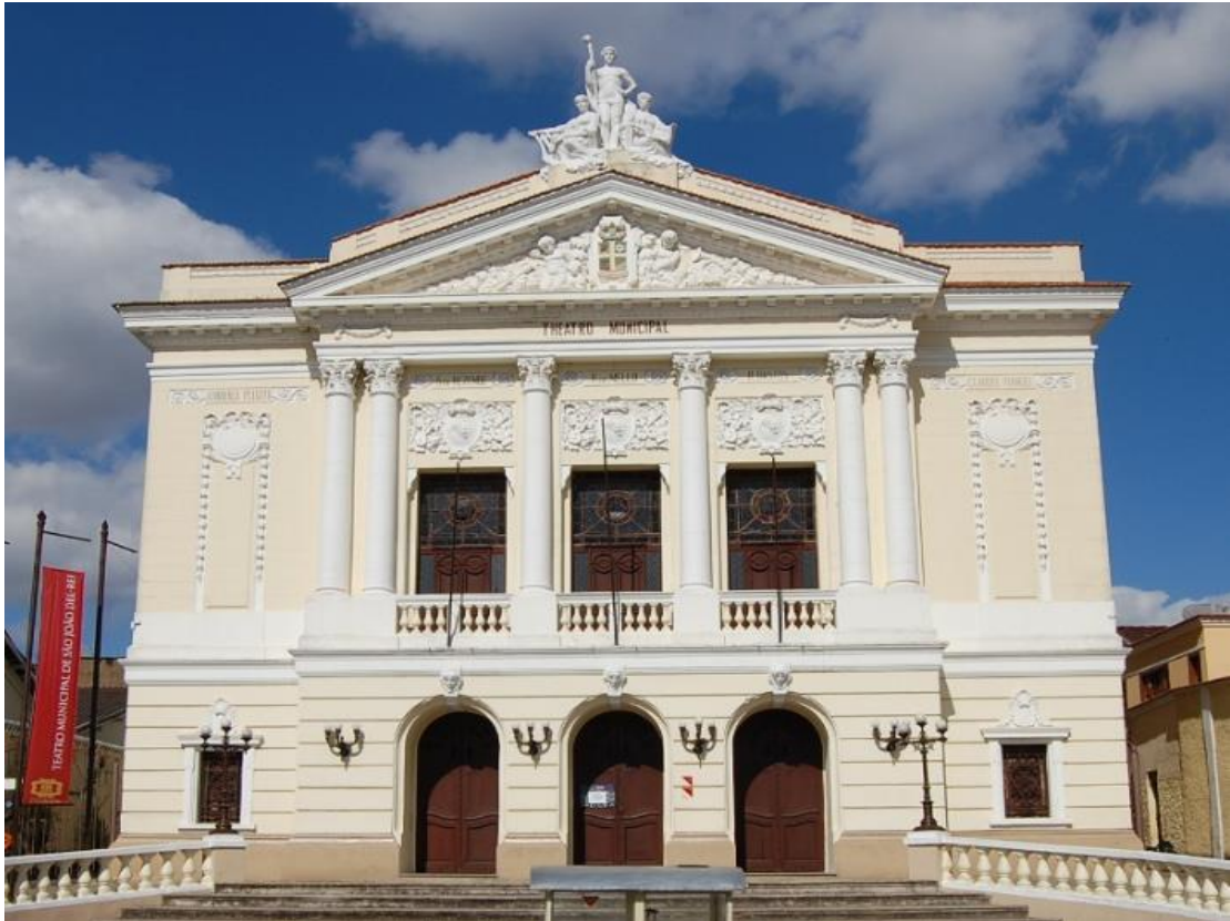
Figura 1 – Vista frontal do Teatro Municipal de São João del-Rei
