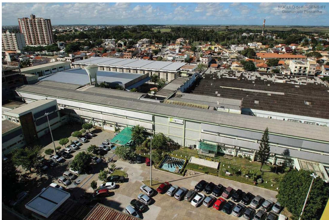
Figura 8 – Vista aérea do IF Fluminense campus Campos-Centro. Imagem de Diomarclo Pessanha.
