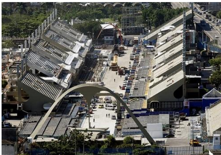
Imagem 1 5 - Sambódromo durante uma obra de ampliação
