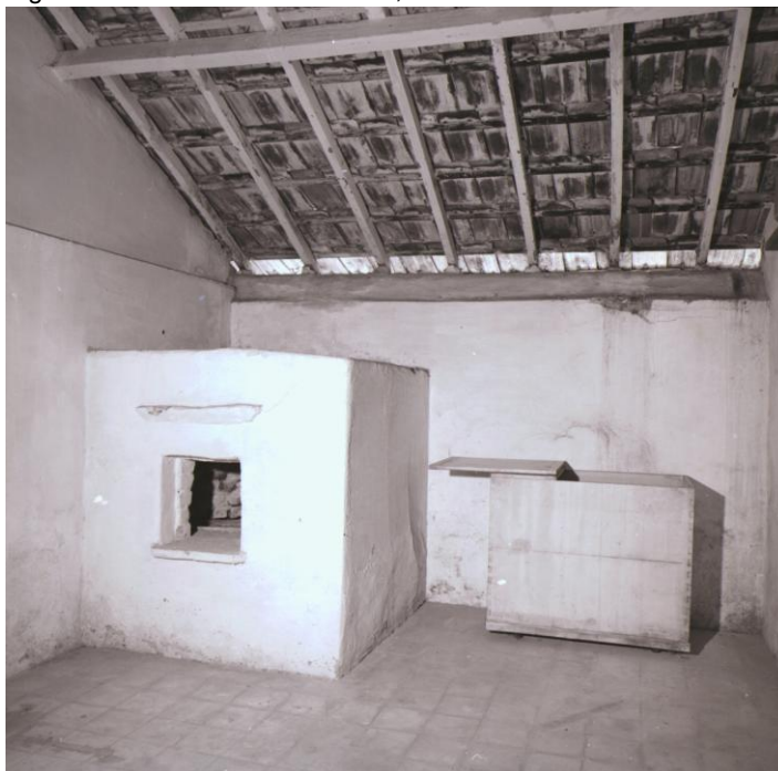
Figura 31: Interior da casa anexa, 1974-1975.
