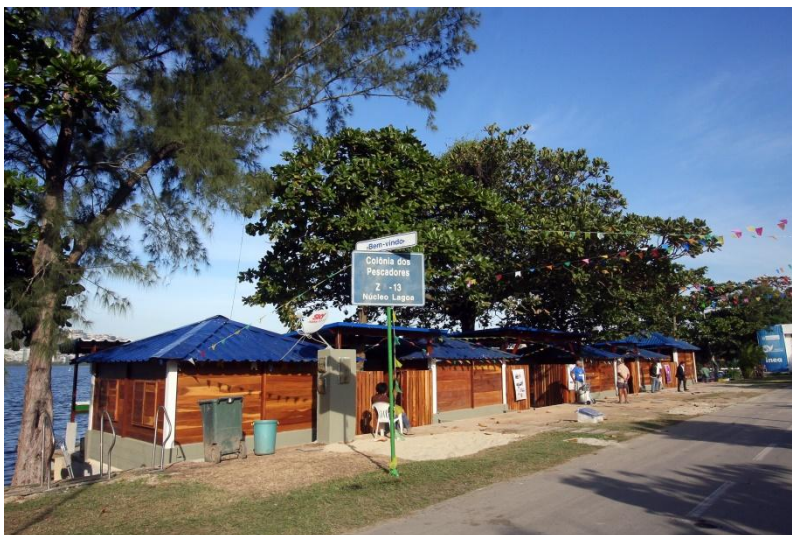
Anexo 5. Estruturas reformadas em 2016 – Foto: Jaqueline Machado
