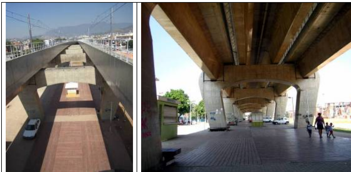
FIGURA 65: Imagens do elevado. Fonte: Fotos da autora.
