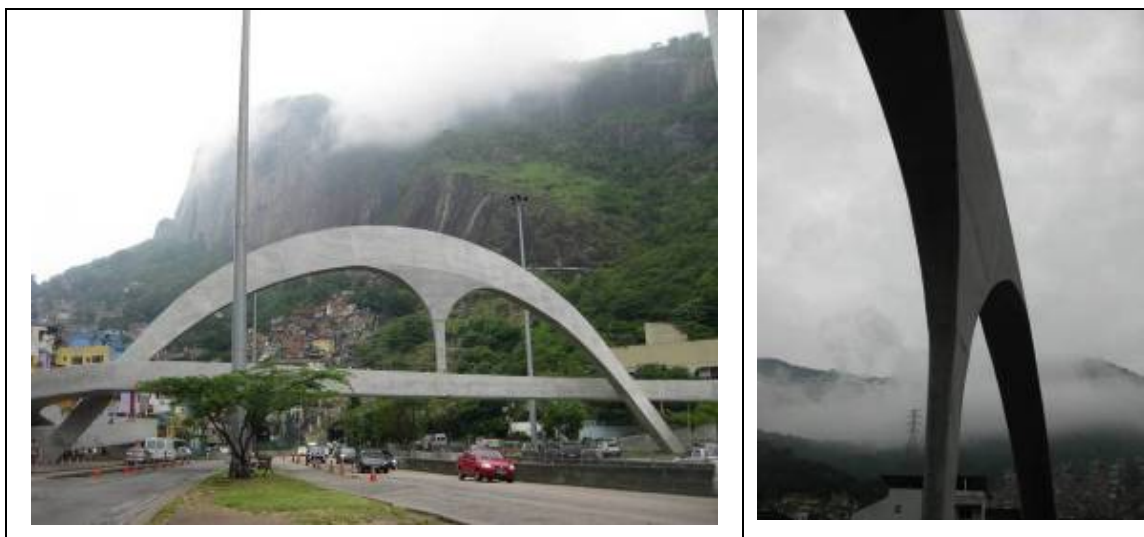
FIGURA 31: Passarela Oscar Niemeyer na favela da Rocinha. Fonte: Arquivo pessoal. Foto da autora
