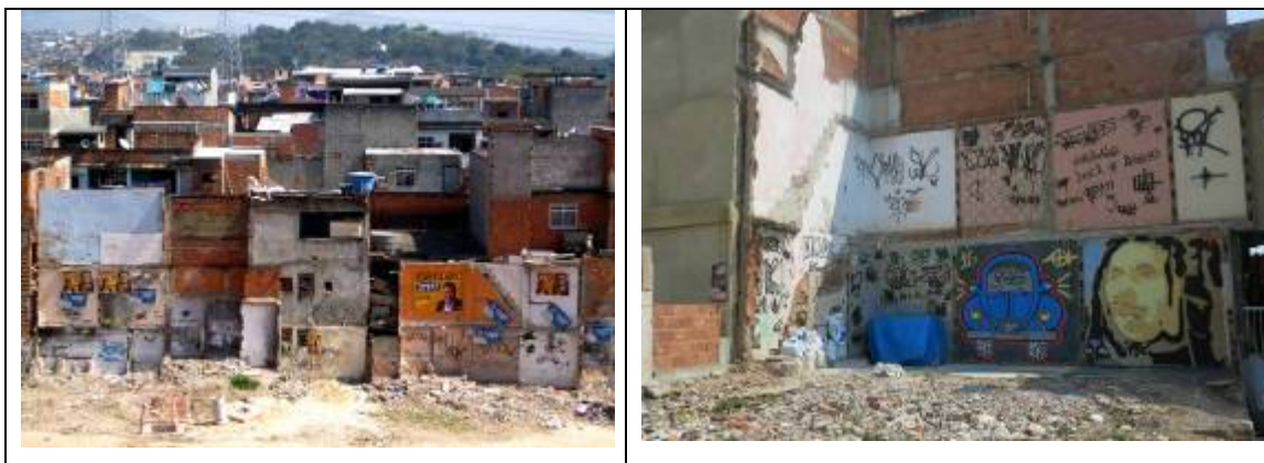
FIGURA 68: Moradias demolidas na avenida Leopoldo Bulhões Fonte: Arquivo pessoal. Foto da autora
