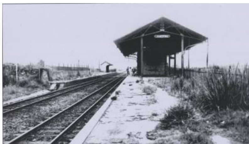
FIGURA 52: Estação de Trem de Amorim Fonte: http://www.estacoesferroviarias.com.br/efl_rj_petropolis/manguinhos.htm
