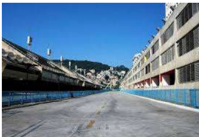
Foto da Passarela do Samba Original (Sambódromo - RJ)
