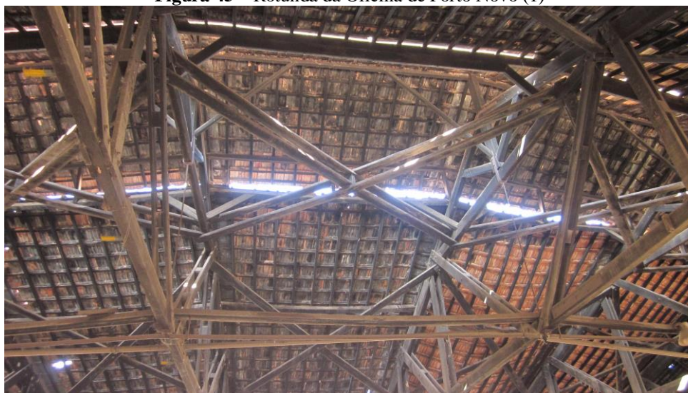
Figura 45 – Rotunda da Oficina de Porto Novo (1)
