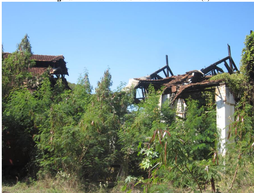
Figura 47 – Rotunda da Oficina de Porto Novo (3)
