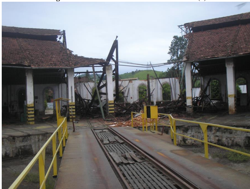
Figura 46 – Rotunda da Oficina de Porto Novo (2)
