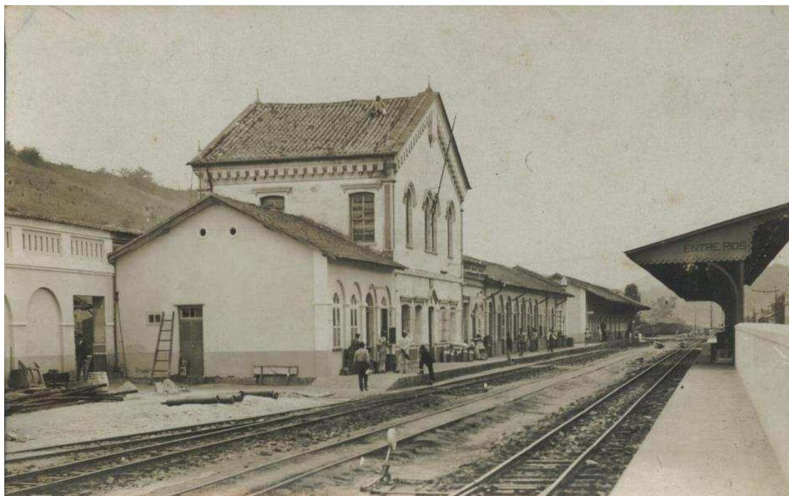
Figura 12 - Estação de Entre-Rios – Década de 20 Fonte: www.estacoesferroviarias.com.br/efcb_rj_linha_centro/tresrios.htm .
