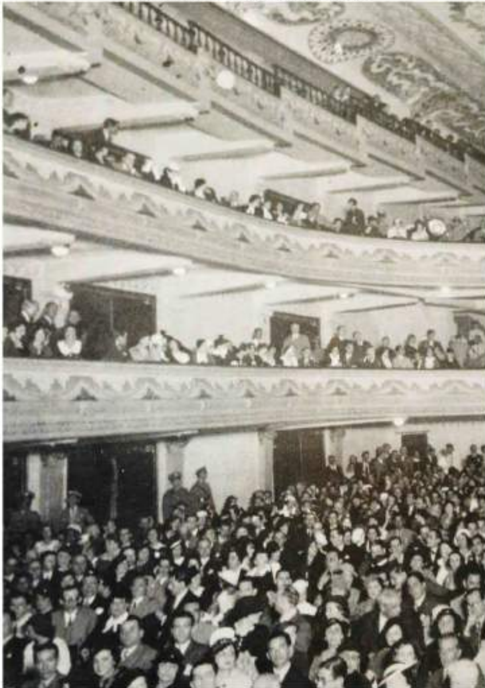
FIGURA 29 Palácio-Teatro (provavelmente em 1928) 1 após ser reconstruído por Serrador: o cinema que inaugurou a era dos grandes salões
