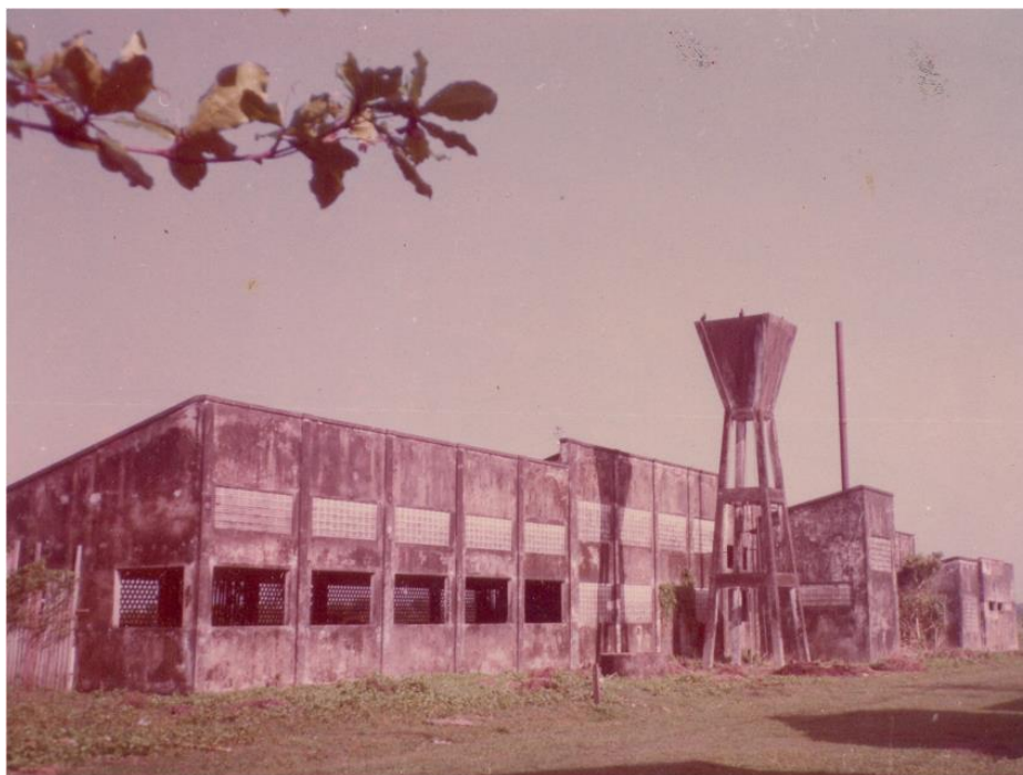
Figura 15: Prédio da antiga Oleica S.A. Fonte: O Museu do Marajó Autor: Giovanni Gallo, sd
