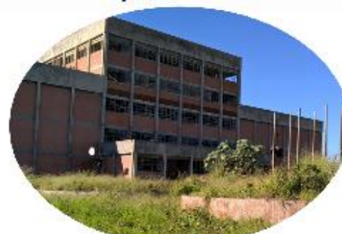
Construção do novo prédio da usina
