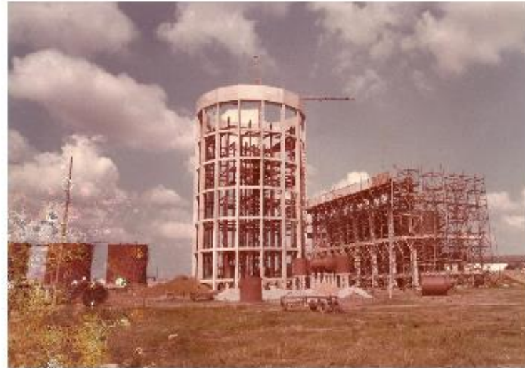
Construção da destilaria
