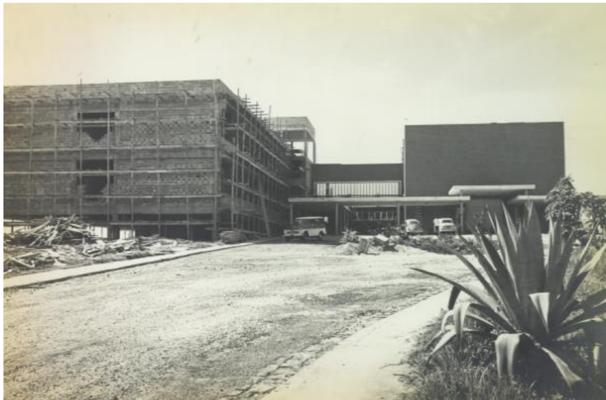
Figura 1 - foto do prédio do IEN em construção. Acervo MAST. Sem autoria e data determinadas.
