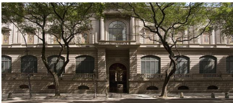
Figura 13: Fachada do prédio da Escola Nacional de Belas Artes, [20-?]. Fonte: http://www.cultura.rj.gov.br/espaco/museu-nacional-de-belas-artes-1 .
