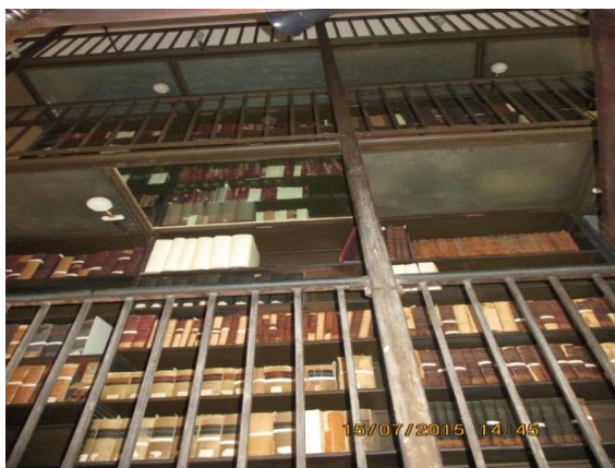
Figura 2 - Estanterias de aço com varandas ao entorno
