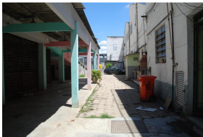
Figura 37 - Fotografia área externa II
