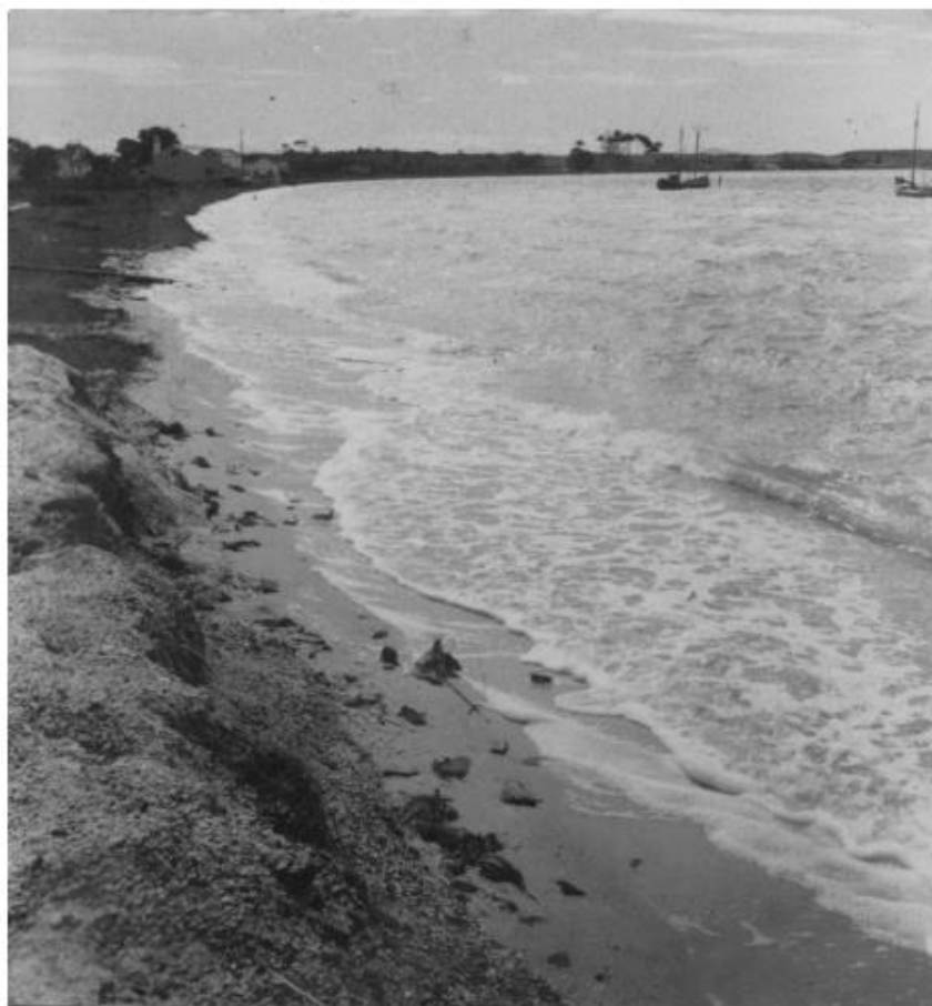
Fotografia 23: Cabo Frio (RJ) : [Praia do Forte]
