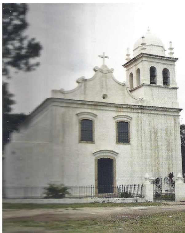
Imagem 9 – Igreja Matriz de Nossa Senhora do Pilar do Iguacu.
