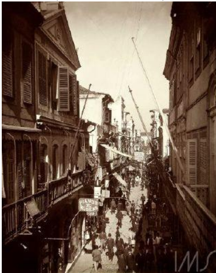
Foto 1 – Rua do Ouvidor, com Escola Politécnica ao fundo, atual IFCS/UFRJ. 1890.
