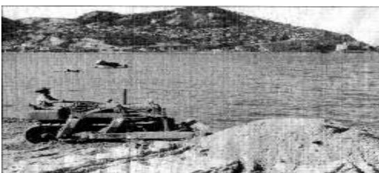
14 O tratorista aplaina a orla da parte antes ocupada pela Praia do Pinto e ao fundo, está a favela que ocupa toda a encosta da Curva do Calombo até o Sacopã A FAFEG organizou. a resistência contra as remoções das favelas da zona sul. (favelas da Curva do Calombo até o Sacopã. sem data)
