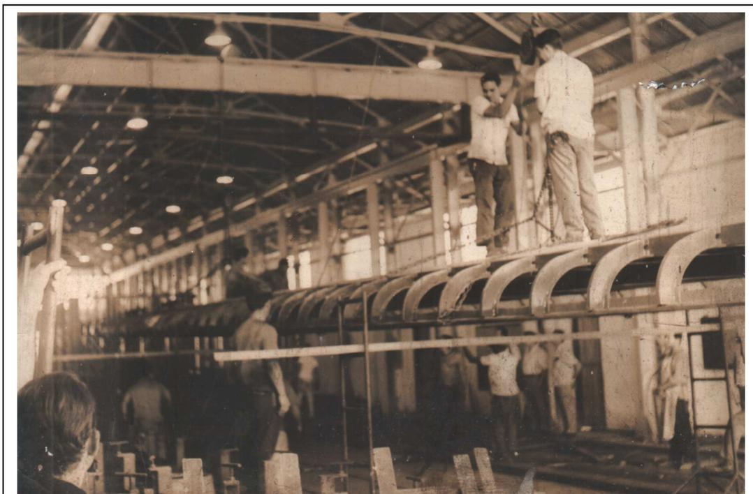
Figura 21: Trabalhadores atuando na construção de vagões de aço para passageiro, momento em que está sendo erguida a estrutura do teto. Provavelmente início dos anos 1970.
