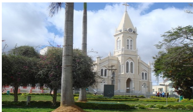
Figura 3 - Igreja de Nossa Senhora das Vitórias
