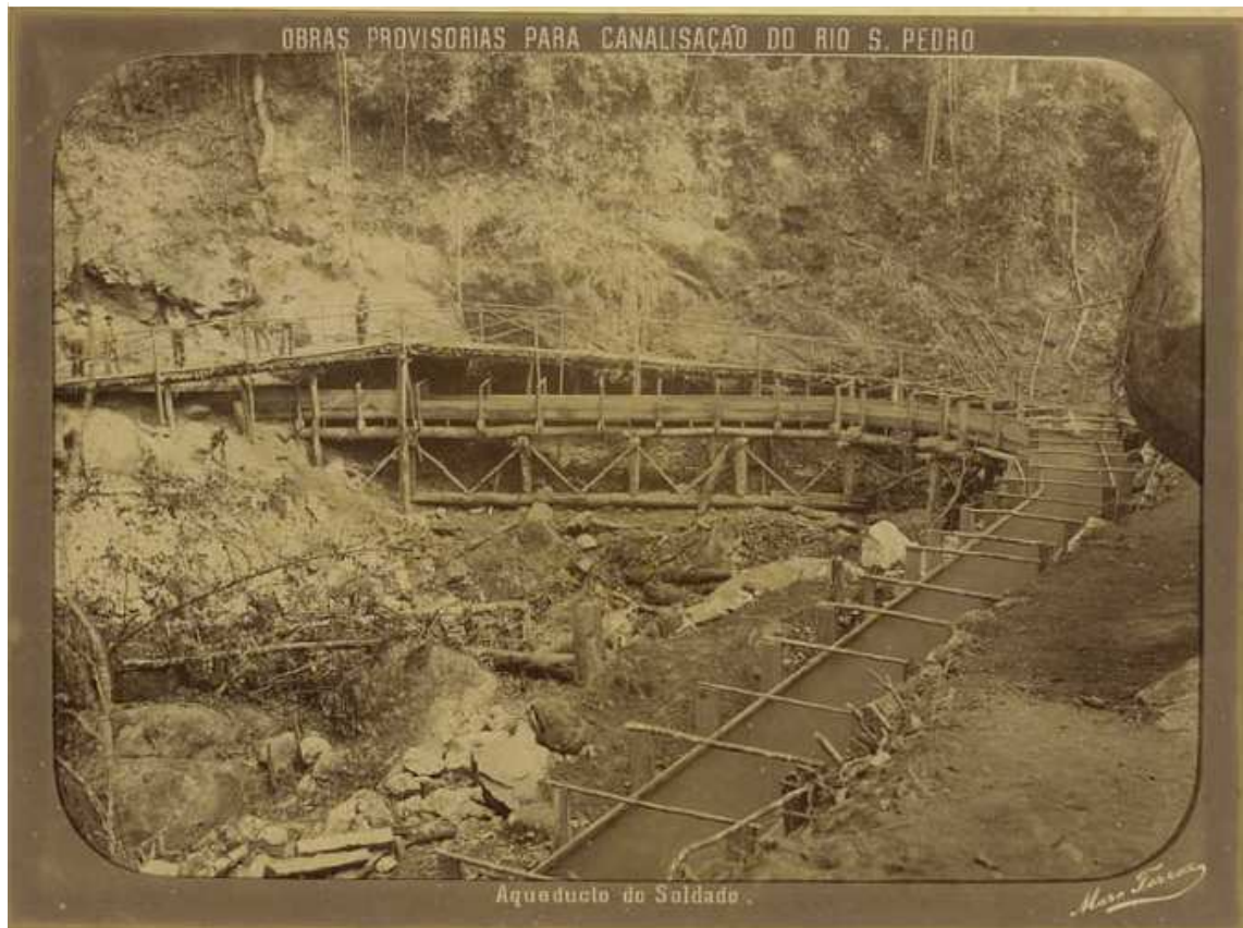
Imagem 24 – Aqueduto do Soldado (Serra do Tinguá)
