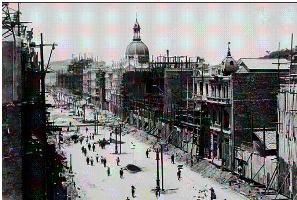
Fig. 3: construção da Avenida Central. A cúpula é do prédio do jornal O PAIZ. Ao lado, a obra do edifício do Clube de Engenharia em estado inicial (Arquivo Geral - RJ)
