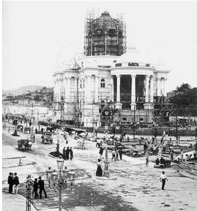
Fig. 5: montagem do Palácio Monroe na Avenida Central (Arquivo Geral - RJ)
