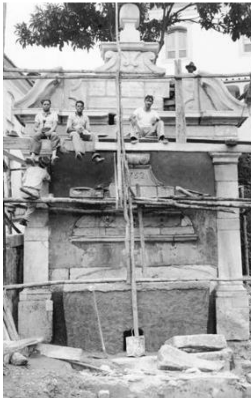
Fig. 15: Restauração do Chafariz do Passo, de Antonio Dias, em Ouro Preto, promovido pela Inspetoria de Monumentos Nacionais, 1936. (CPDOC-GC)
