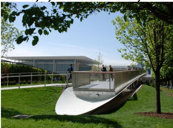
Imagem 11: ART INSTITUTE OF CHICAGO Arquiteto: Renzo Piano Ano: 2009 Localização: Chicago, IL, EUA Fonte: Site Archdaily
