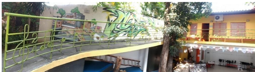
Rampa de acesso para o segundo andar com a grade de ferro que confere segurança aos transeuntes.
