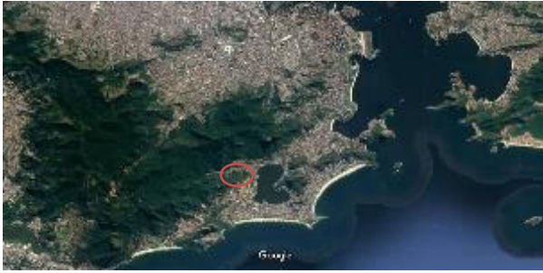
Rio de Janeiro – sítio Patrimônio Mundial Paisagem Cultural (altura do observador 2 km) Escala humana e das relações imperceptível
