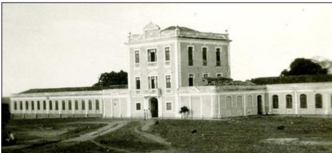
Figura 11 – Prédio onde funcionou a Casa dos Educandos Artífices
