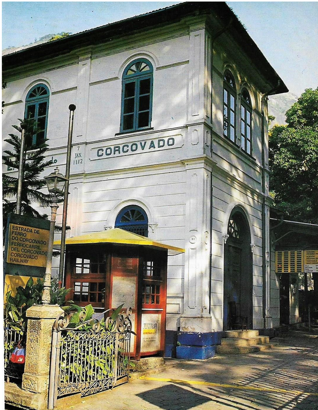
A estação da via férrea que conduz ao Corcovado é passagem quase obrigatória dos visitantes da cidade.
