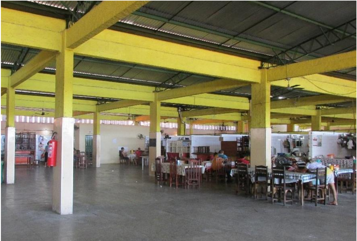
Imagem 20 - Praça de alimentação no segundo piso.
