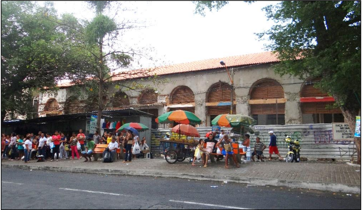
Imagem 4 - Fachada da edificação principal do Mercado durante as etapas finais da reforma.
