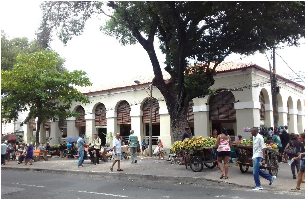
Imagem 21- Edificação principal do Mercado após ser reformada.
