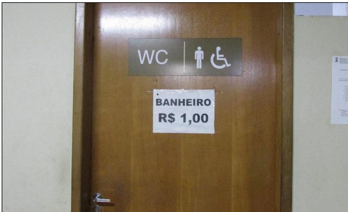
Imagem 23 - Placa em banheiro da parte reformada.
