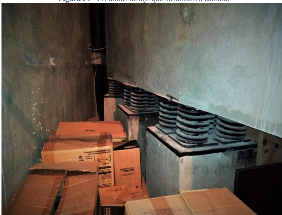
Figura 39 - As molas de aço que sustentam a câmara.
