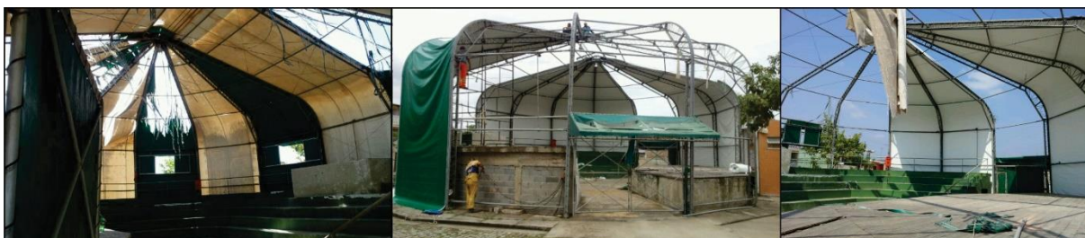
Imagem 98: Registro do andamento da obra feito pela construtora VW, responsável pela reforma - Disponível em: https://pt.foursquare.com/v/construtora-wv-reforma-lona-cultural-sandra-de-sa/500e9df4e4b0bfb6d26127f - acesso em 01/06/2022
