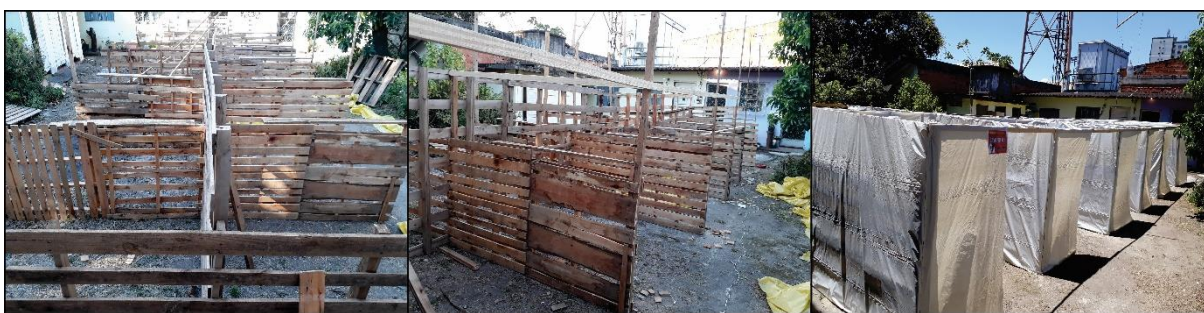
Imagem 49: Construção dos 12 camarins nos fundos do G.M.R. 24 de Fevereiro - Acervo ETAA
