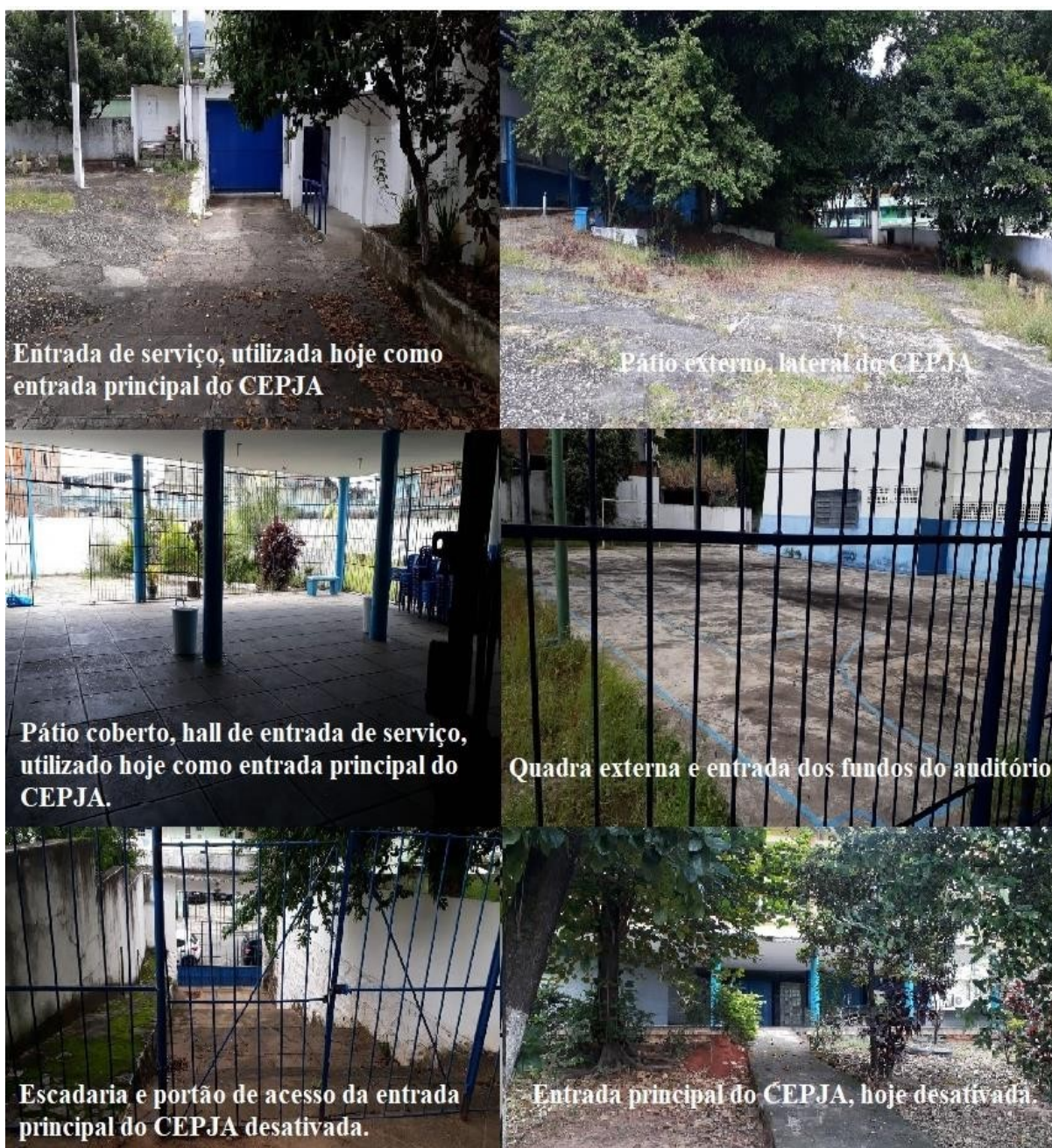
Fotografia 5- Montagem com fotos das instalações da área externa do CEPJA
