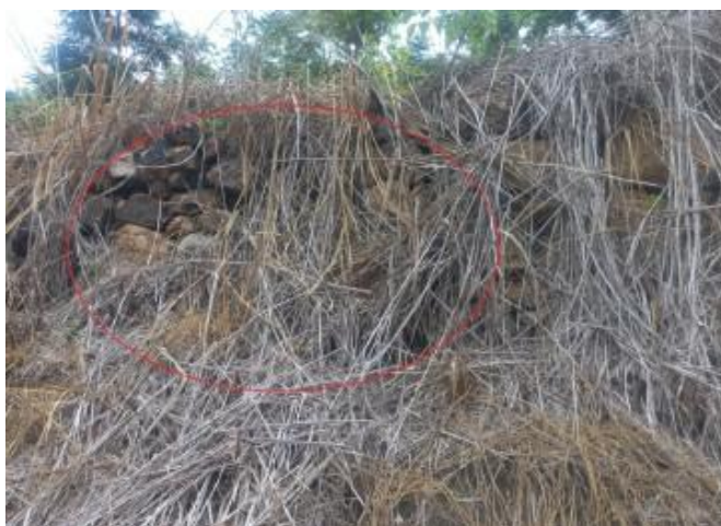
Figuras 19: Muro de contenção
