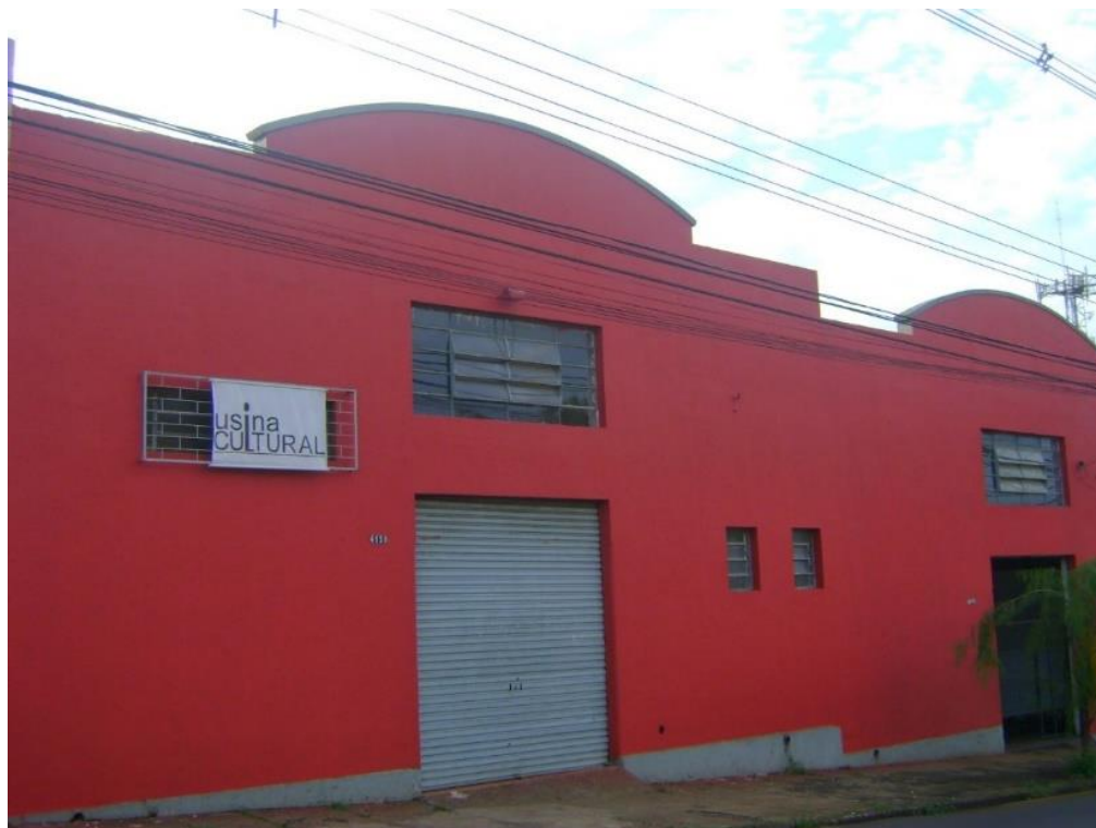
IMAGEM 11: Área externa da vila cultural Usina Cultural 39 .
