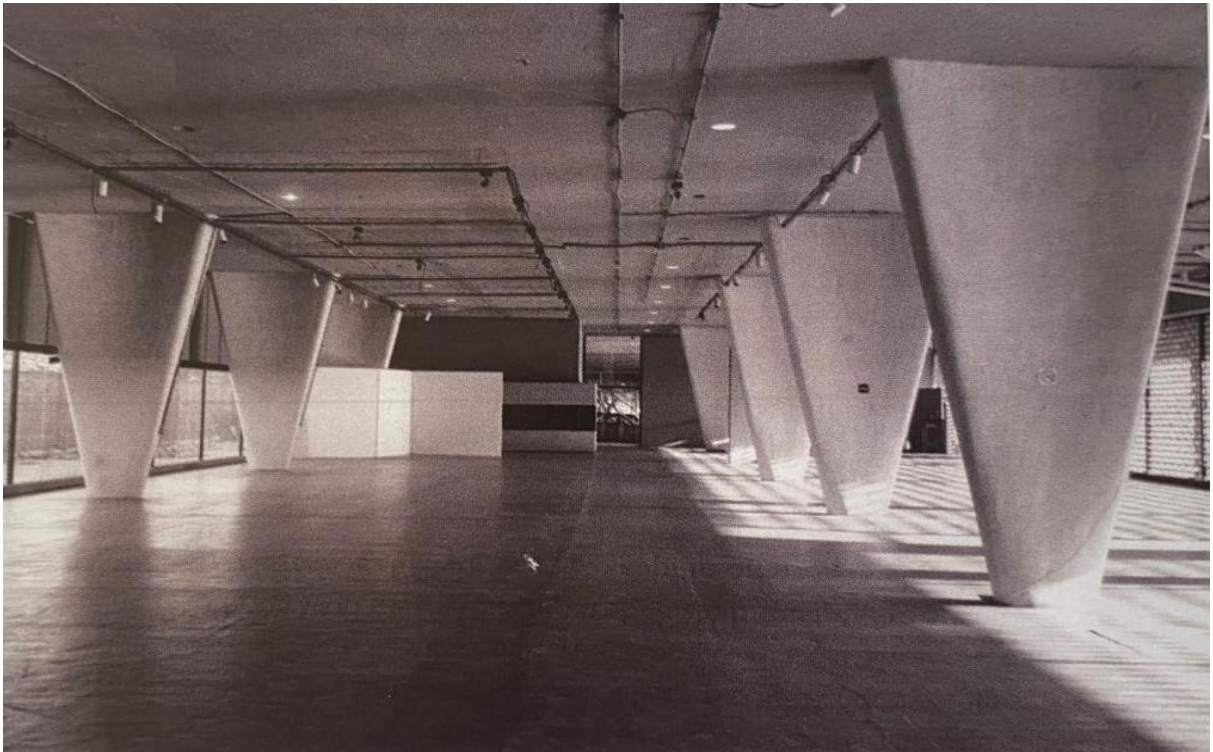
Figura 3 - A imagem retrata o interior do Galpão das Artes, local onde aconteciam os cursos e oficinas de Artes Visuais, Literatura, Vídeoarte e Filosofia. Logo após a inauguração, um tablado de madeira medindo 12m x 6m foi instalado no centro do ambiente para receber as oficinas de Dança e Teatro. Foi neste espaço que a encenação de A divina comédia começou a tomar forma. Foto Vicente de Mello (1990). Acervo MAM-RJ.
