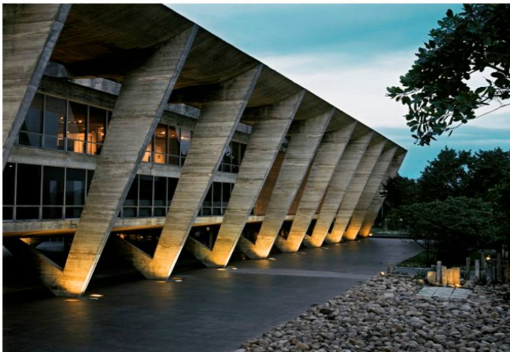
Figura 24 - Vista panorâmica da fachada lateral do MAM-RJ. Esta perspectiva do Museu expõe os grandes pilares de sustentação e os vãos intermediários existentes entre eles assim como parte do jardim externo. Todos os espaços visíveis nesta imagem foram integrados na transposição cênico-coreográfica do Purgatório . Foto Vicente de Mello, s/d.
