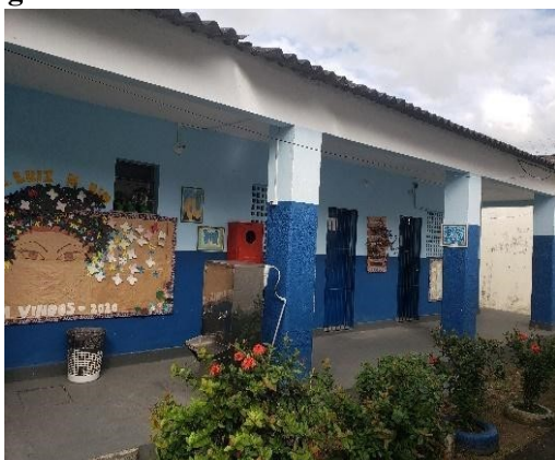
Figura 17 – CELM: acesso às salas de aula
