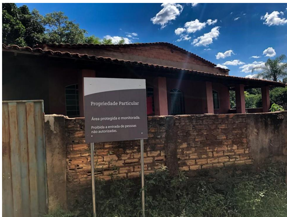
Figura 03. Casa abandonada em Córrego do Feijão
