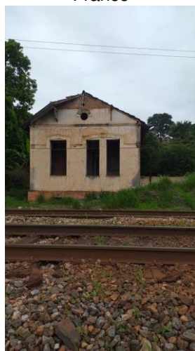
Figura 26 – Estação Ferroviária de Melo Franco
