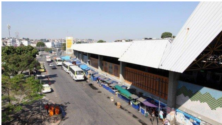
Figura 01 - Estação Metrô Pavuna, em 10/06/2020
