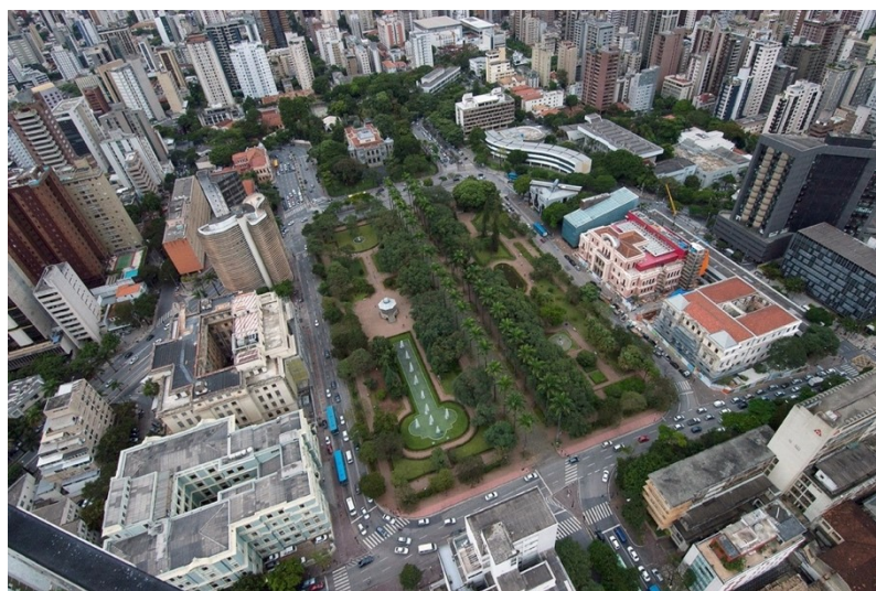
Figura 18 - Vista aérea da Praça da Liberdade após 2010 (data não informada).
