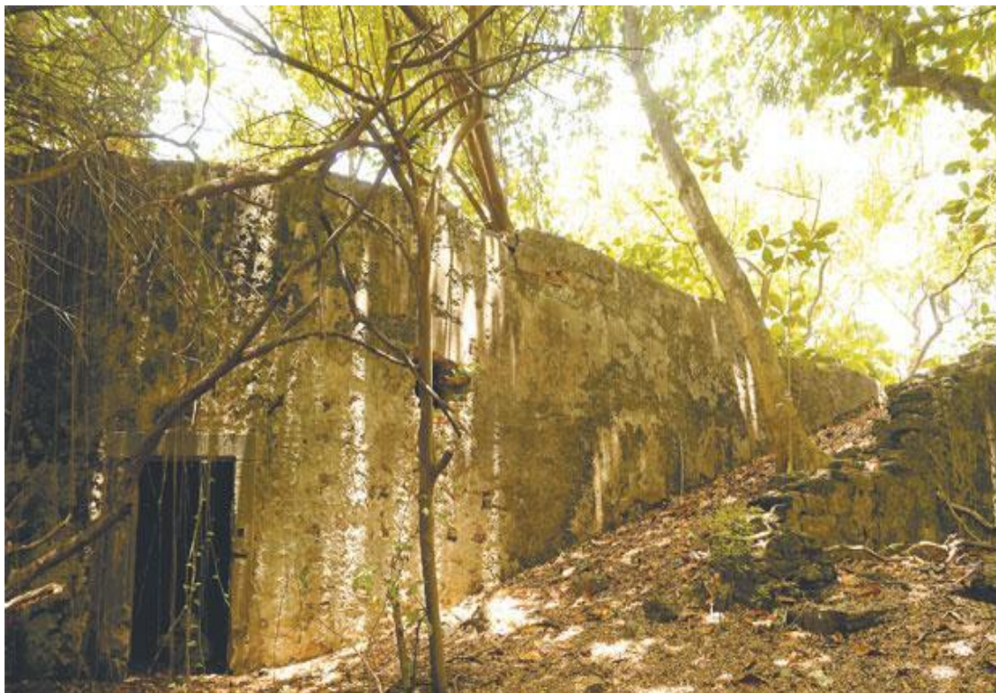
Figura 18: Ruínas do Forte do Buraco
