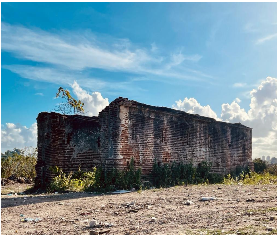
Figura 19: Ruínas da Pólvora
