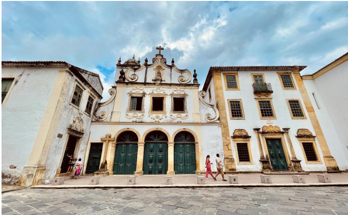
Figura 30: Igreja e Convento de São Francisco
