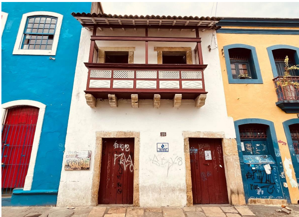
Figura 23: Casa com Muxarabi Árabe de nº28 da rua do Amparo
