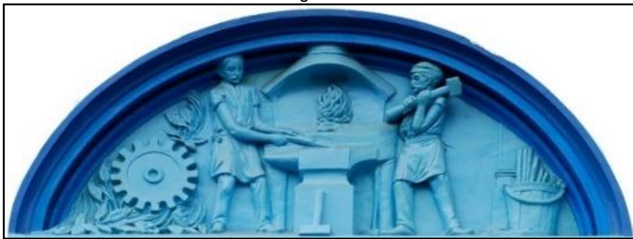
Figura 29- Detalhe de um dos nichos da fachada da antiga Fábrica de Fogões Progresso 146
