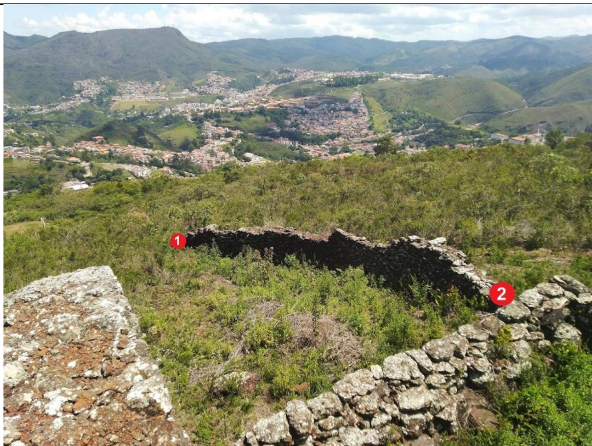
Figura 19: Demonstrativo entre ponto 1 e ponto 2, ilustração de marcação de pontos na estrutura selecionada para mapeamento, coordenadas ponto 2: 23K 657075.10 m E / UTM 7745583.56 m S, 2019.
