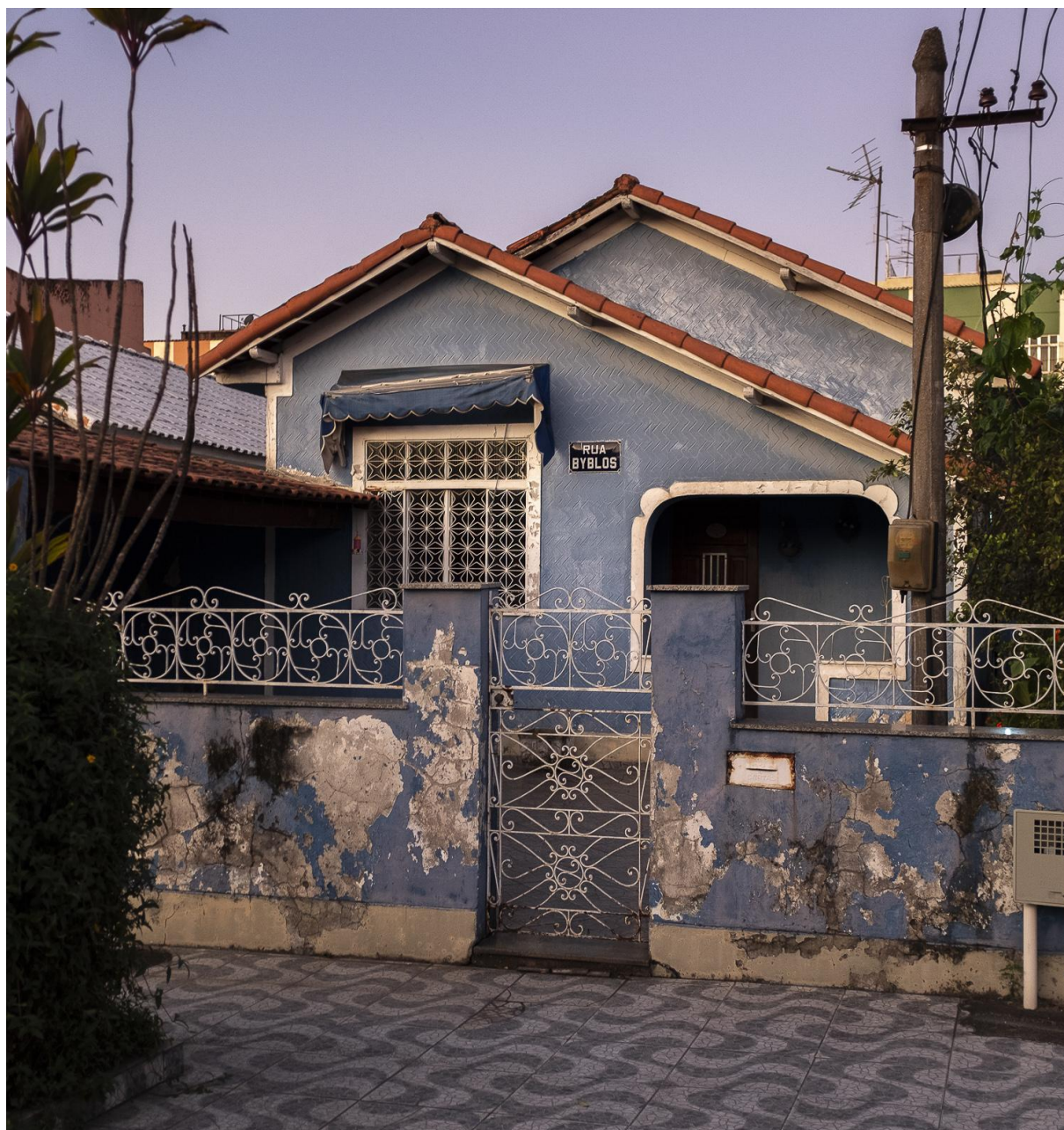
Figura 88 – Fotografia de casa tradicional do Bairro Jabour
