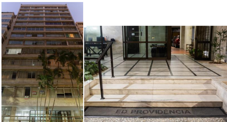
Figuras 31 e 32 – Fotografias do Edifício Providência
