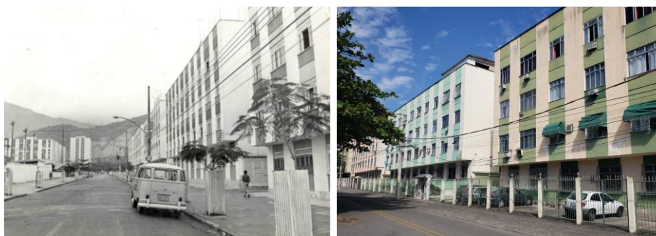
Figuras 52 e 53 – Fotografias dos prédios de quatro andares na Rua Raul Azevedo
