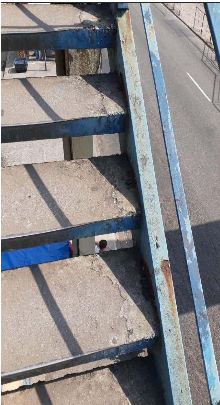
Figura 85 – Passarela próxima da Estação Leopoldina (escadas)
