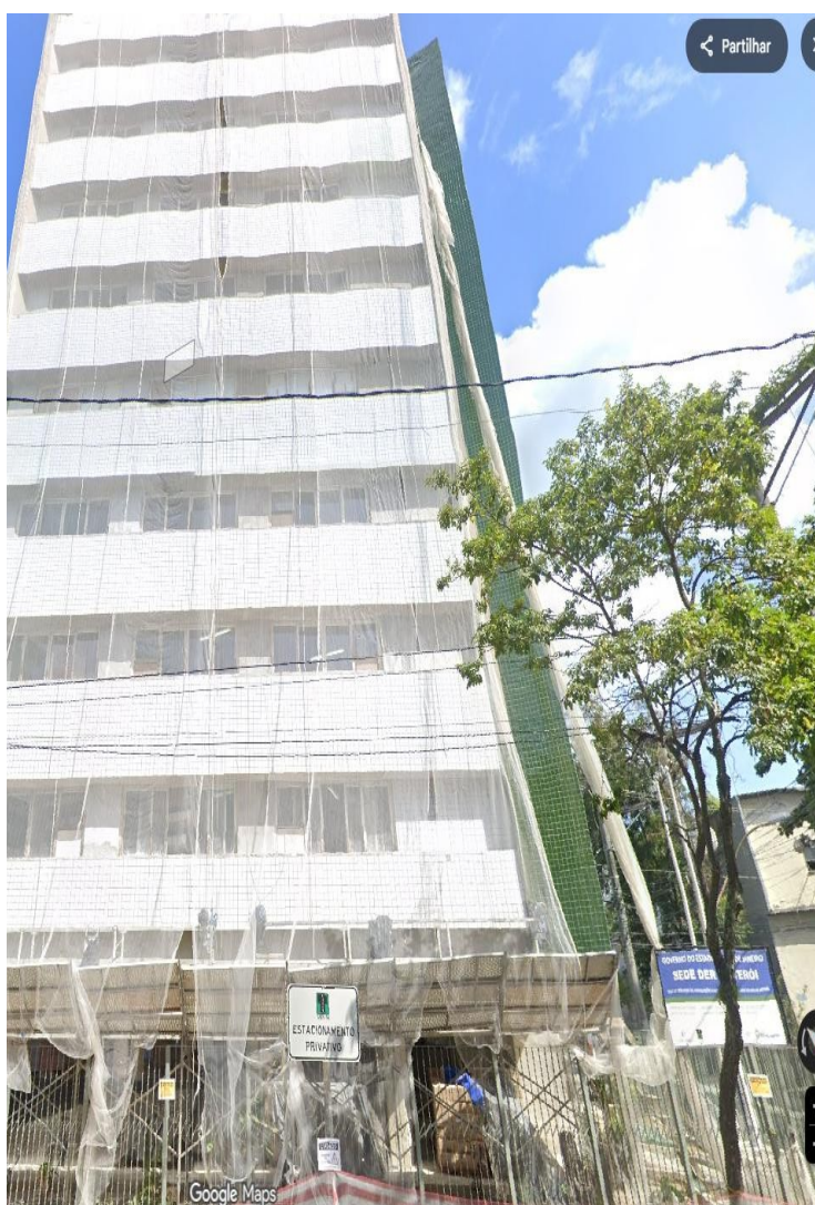
Figuras 55 - Edifício-sede do DER-RJ Rua Prof. Heitor Carrilho – Niterói.
