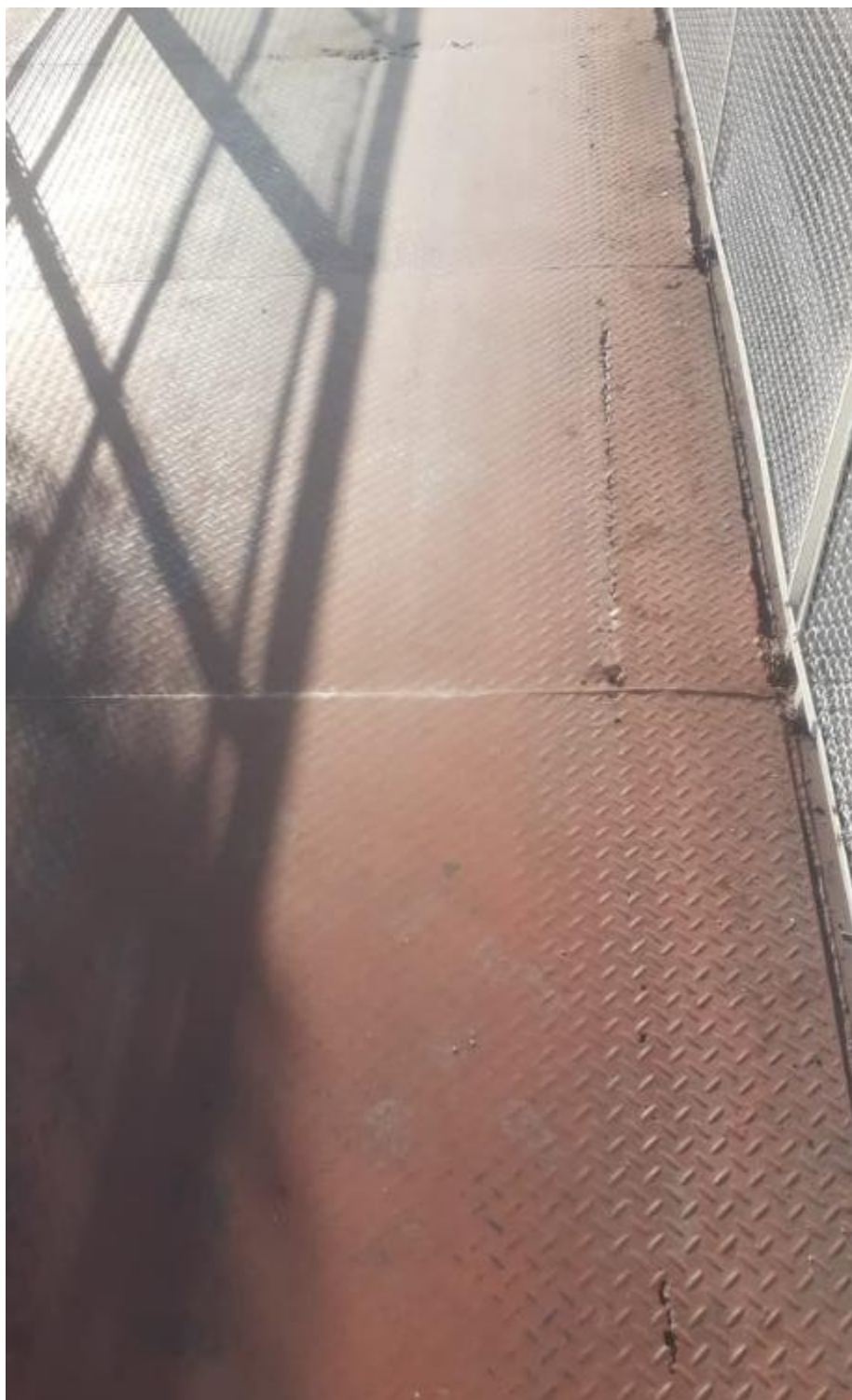
Figura 41 - Passarela da Estação Leopoldina - meses após a reforma (piso contínuo do mesmo jeito).
