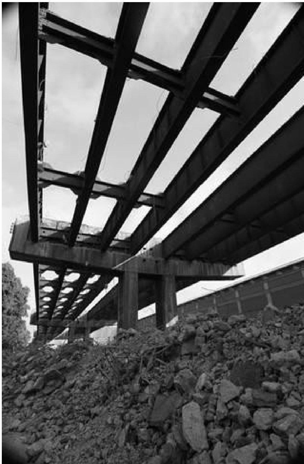
Figura 4 – Vigas do Elevado da Perimetral, após a implosão do elevado, na cidade do Rio de Janeiro.
