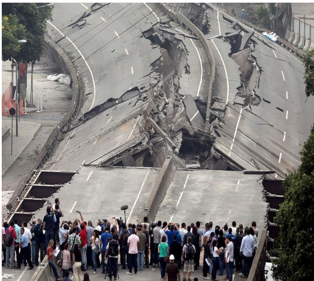
Figura 3 – Implosão do Elevado da Perimetral (Engenheiro Freyssinet) na cidade do Rio de Janeiro.
