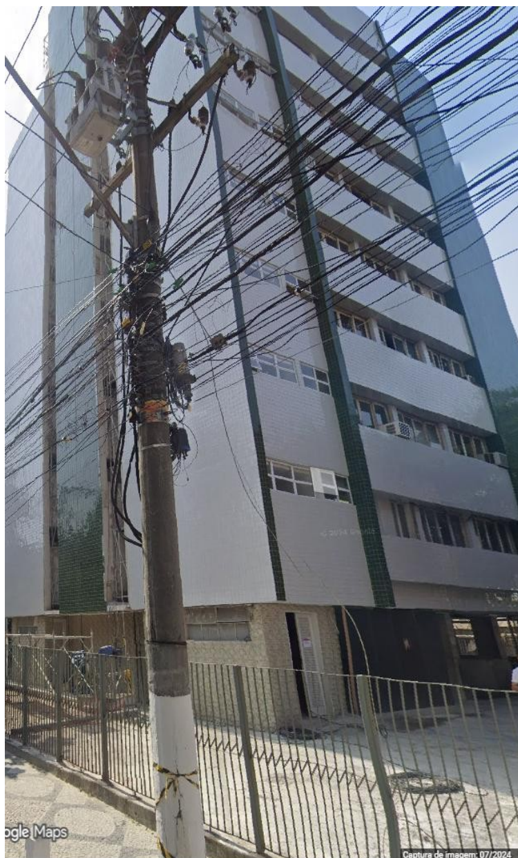
Figura 56 - Edifício-sede do DER-RJ, vista da Rua Visconde Sepetiba-Niterói.
