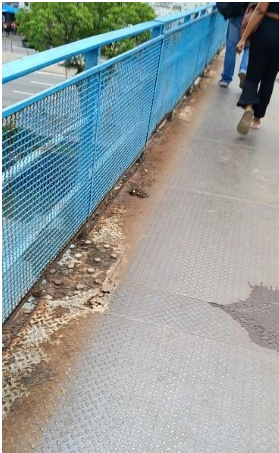
Figura 86 – Passarela próxima da Estação Leopoldina (guarda corpo lateral)
