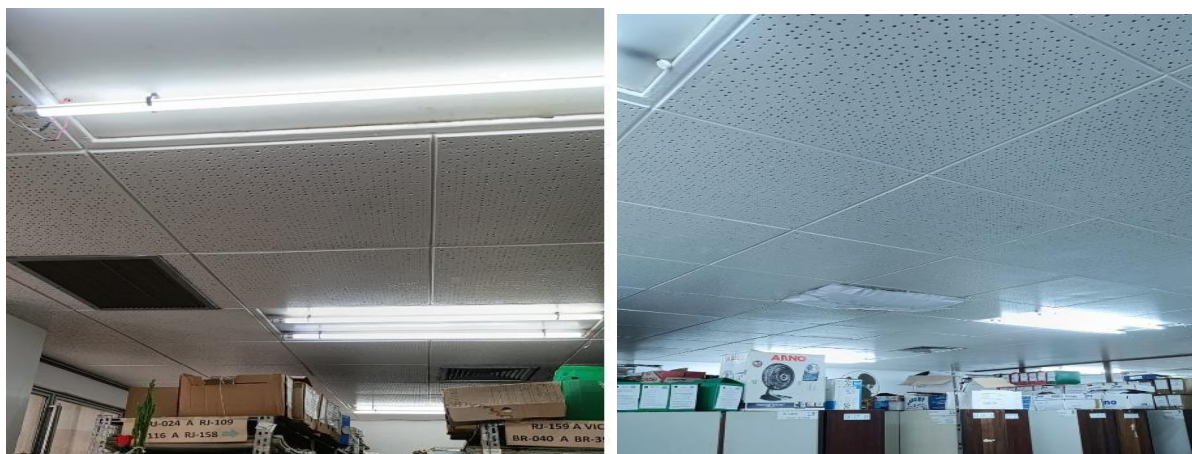
Figuras 33a e 33b – Iluminação e placas de drywall no teto.
