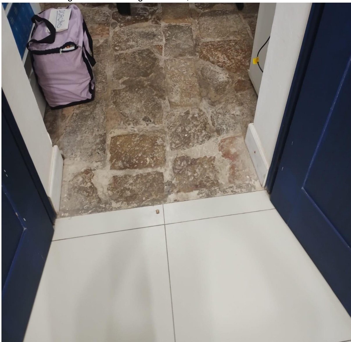
Figura 6 - Piso antigo e o novo, resultado da última reforma
