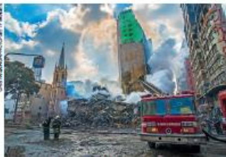
Desabamento de edifício ocupado por famílias de baixa renda no Largo do Paissandu, no centro de São Paulo (SP), em 2018. Mais de noventa famílias perderam a moradia e seus pertencimentos. A falta de política de habitação afeta principalmente as populações negras das cidades brasileiras.
